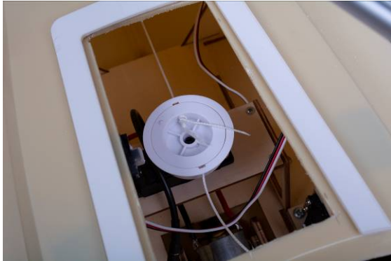
Abb. Segelwinde montiert
