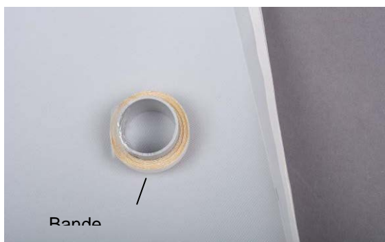
Vue: pose de la bande adhésive
